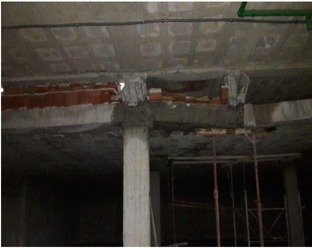
Foto 3. Kavajë (Albania, dec. 2019) - Bloc P+4E cu structura în cadre din beton armat (efect de stâlp scurt)
