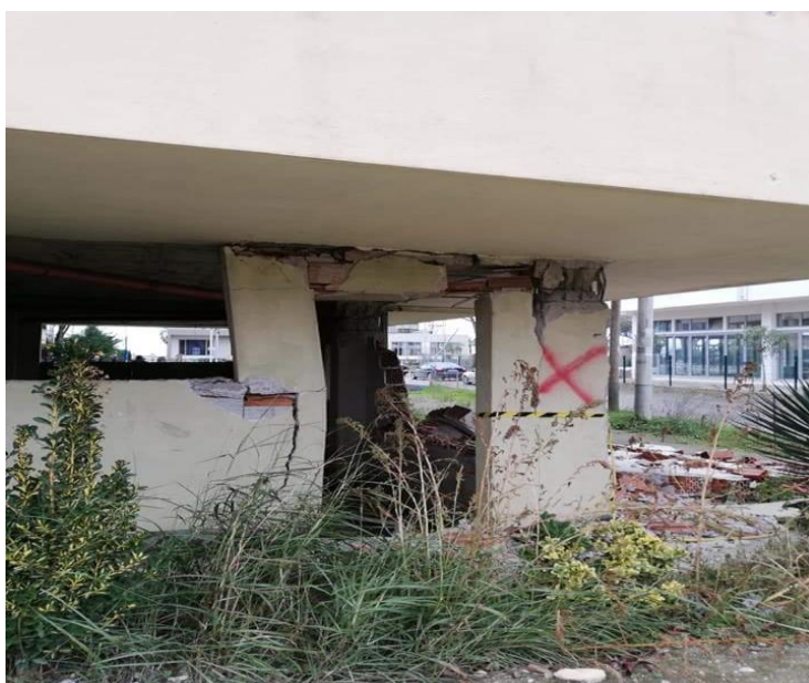
Foto 2. Durrës (Albania, dec. 2019) - Bloc P+4E cu structura în cadre din beton armat
