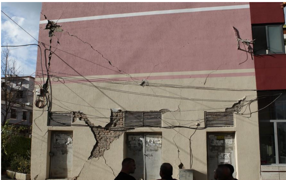
Foto 1. Vorë (Albania, dec. 2019) - Bloc de locuințe P+4E din zidărie de cărămidă plină
