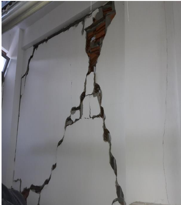
Foto 4. Kavajë (Albania, dec. 2019) - Bloc P+3E cu structura din din beton armat (zidărie defectuoasă-concepție+materiale)
