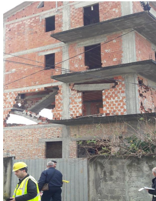
Foto 4. Kavajë (Albania, dec. 2019) - Bloc P+3E cu structura din din beton armat (zidărie defectuoasă-concepție+materiale)
