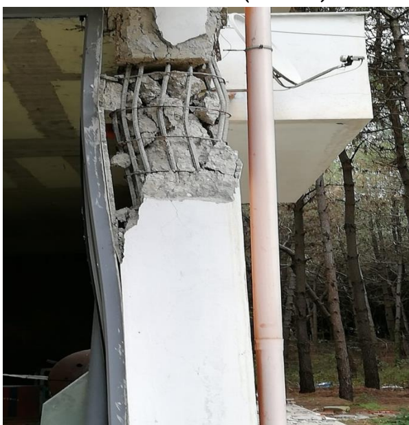
Foto 2. Durrës (Albania, dec. 2019) - Bloc P+4E cu structura în cadre din beton armat
