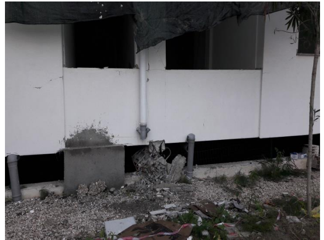
Foto 3. Kavajë (Albania, dec. 2019) - Bloc P+4E cu structura în cadre din beton armat (efect de stâlp scurt)
